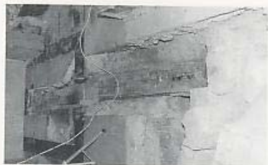
b. Golgotha, Kreuzigungsstelle, NO-Ecke links vom Altar. Nach Entfernung der Steinplatten sind Teile von früheren Bodenresten sichtbar.
