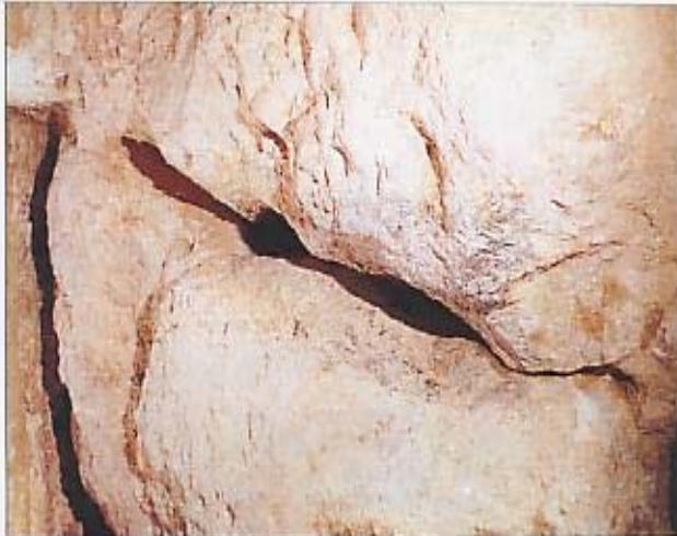
2. Αποψη της μεγάλης διαμετρικής ρωγμής του Ιερού Βραχίου του «φρικτού Γολγοθά».
