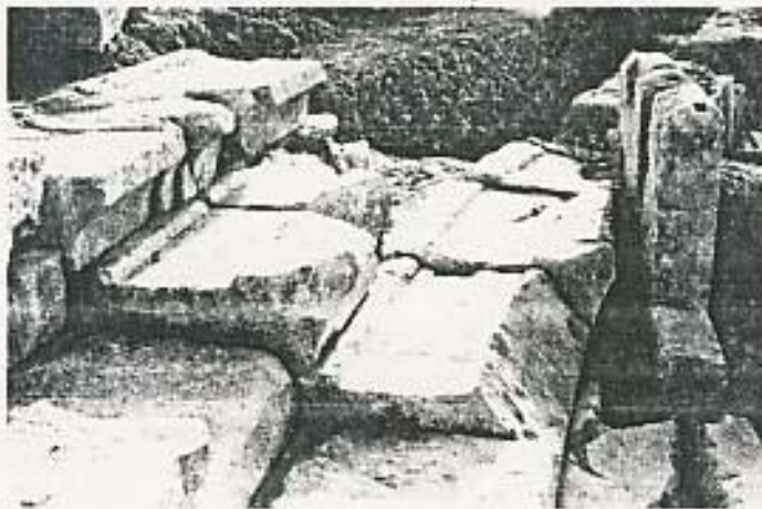
Εικ. 8. Μασόνεια, Θύατρο: Προετοιμαγή σφραγισμάτων με λοξό κόψιμο της πρώτης οδοπέδου στο ΝΑ πέρασ του ημικυκλίου της ορχήστρας
