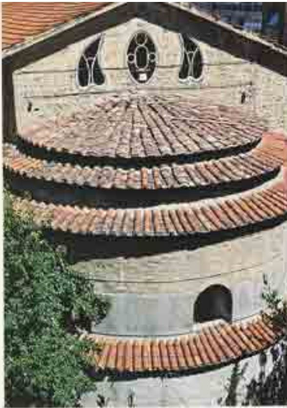
Ναός Αγίου Μηνά. Ανατολική πλευρά. Η κόψη του νερού με τους ελλειψοειδείς και καρδιοειδή φεγγίτες.
